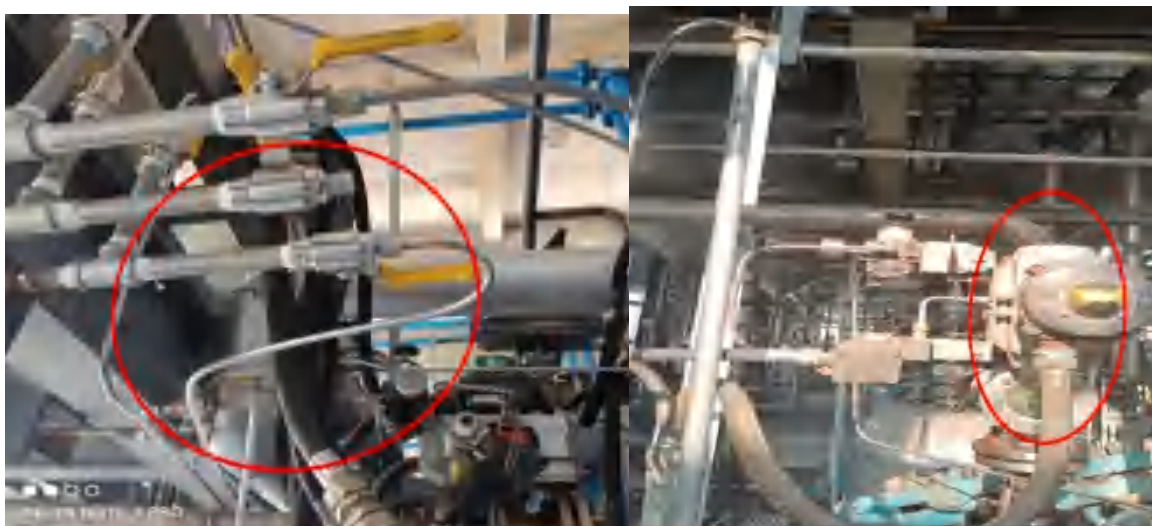
40-11 对氨、三氨加氢釜已设置冷却水流量检测仪表。
