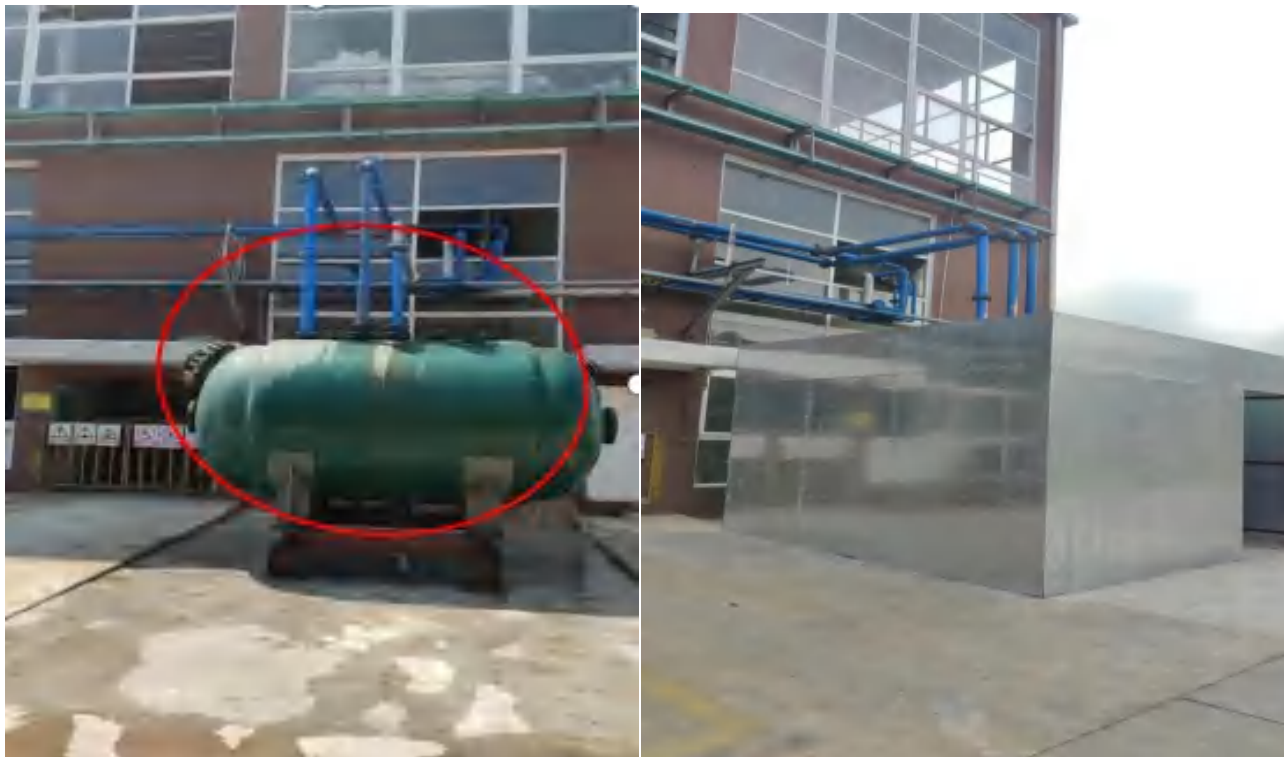
40-13 亚硝化釜事故应急槽已采取防止二次爆炸、火灾的安全措施。
