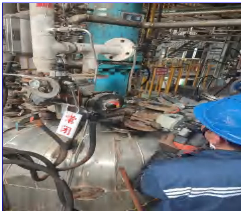
加氢釜放空系统增加自控阀，保持加氢釜放空系统与设计图纸一致
