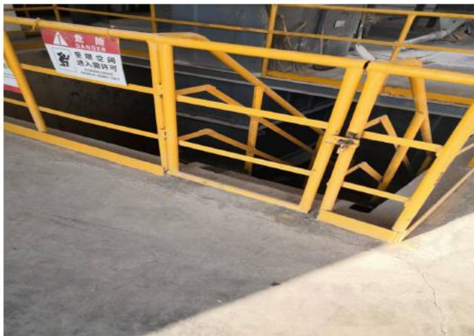
附件 3（斗提机深基坑挂牌上锁）
