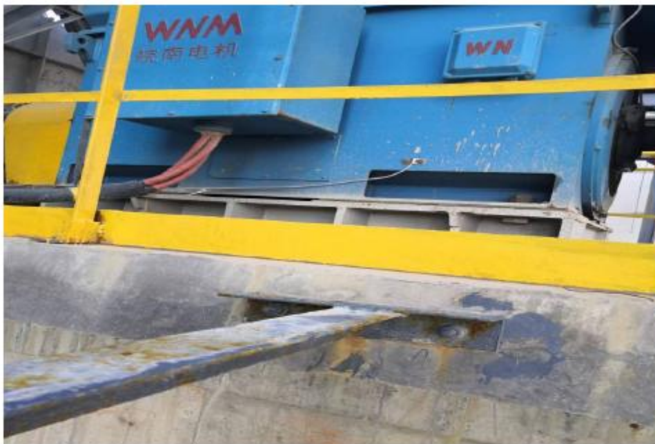
附件 5（完善电机保护性接地）
