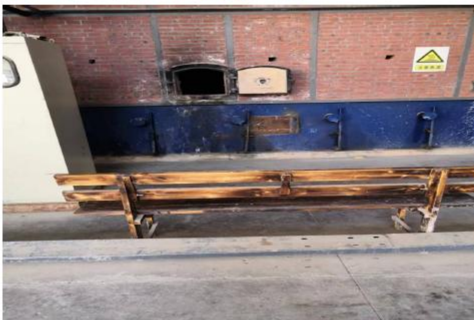
附件 6（热风炉旁设置的临时操作间已拆除）
