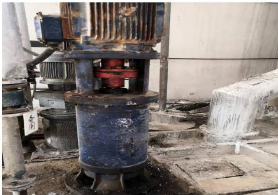
附件 4（恢复拆除的备用设备）
