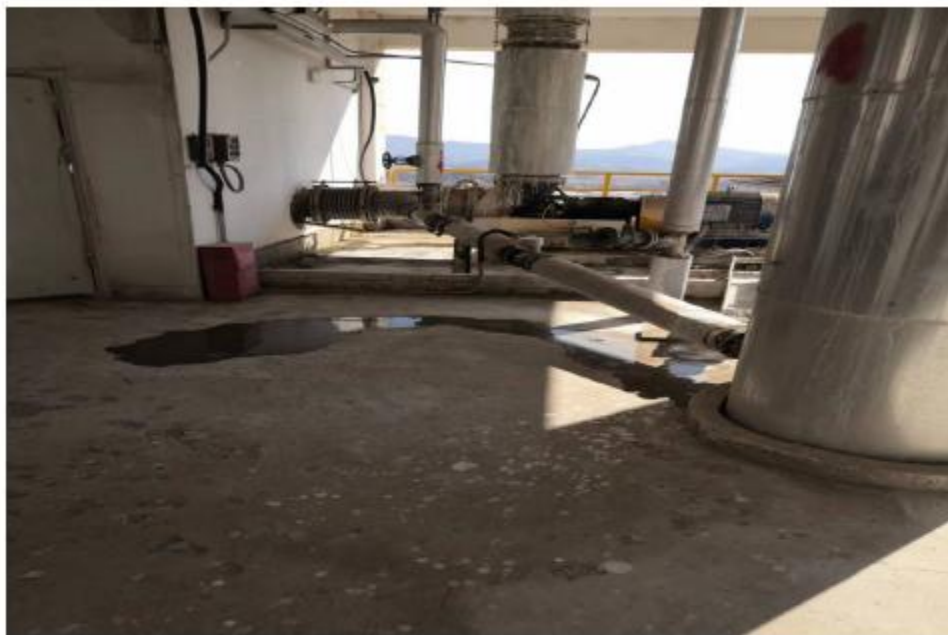
附件 10（临时接管已拆除）
