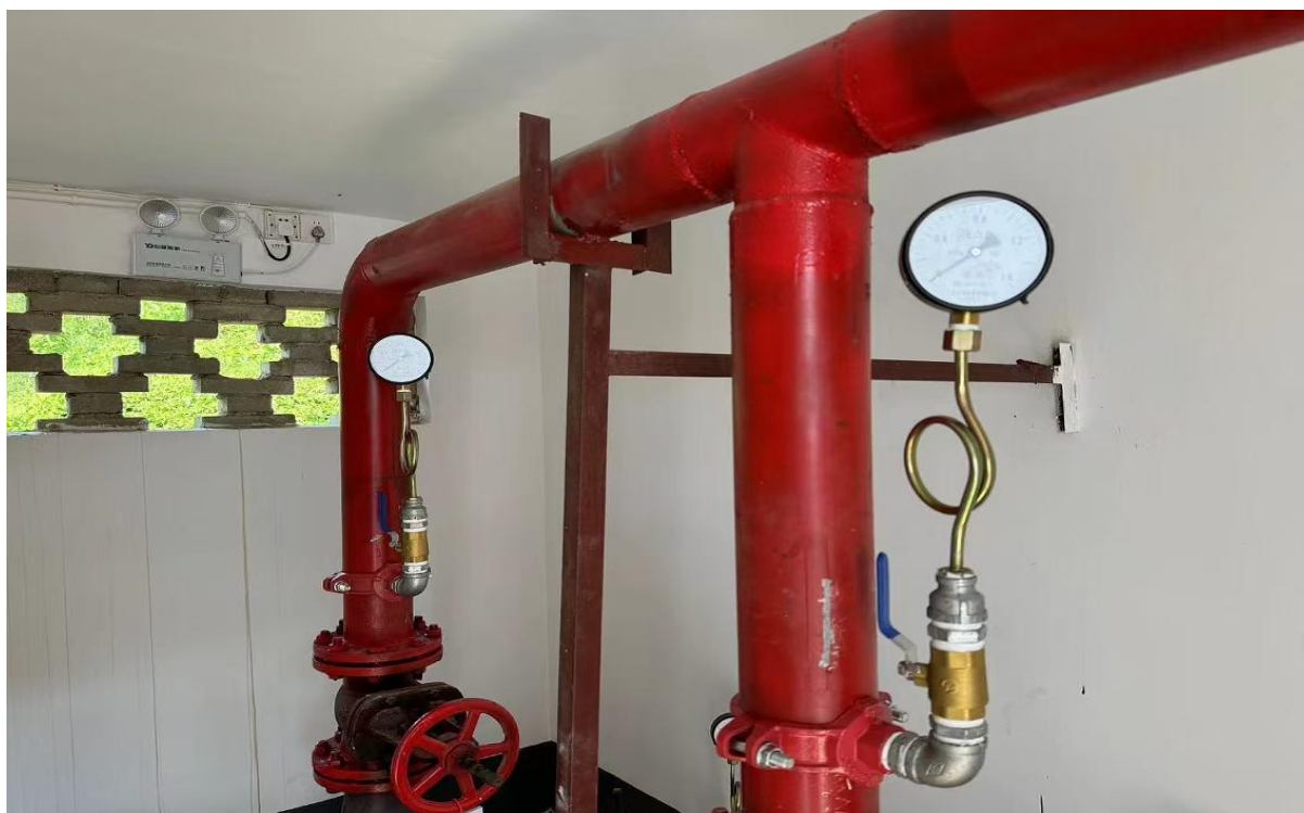
(3) 消防水泵出水管道和给水管道已安装压力表 整改后
