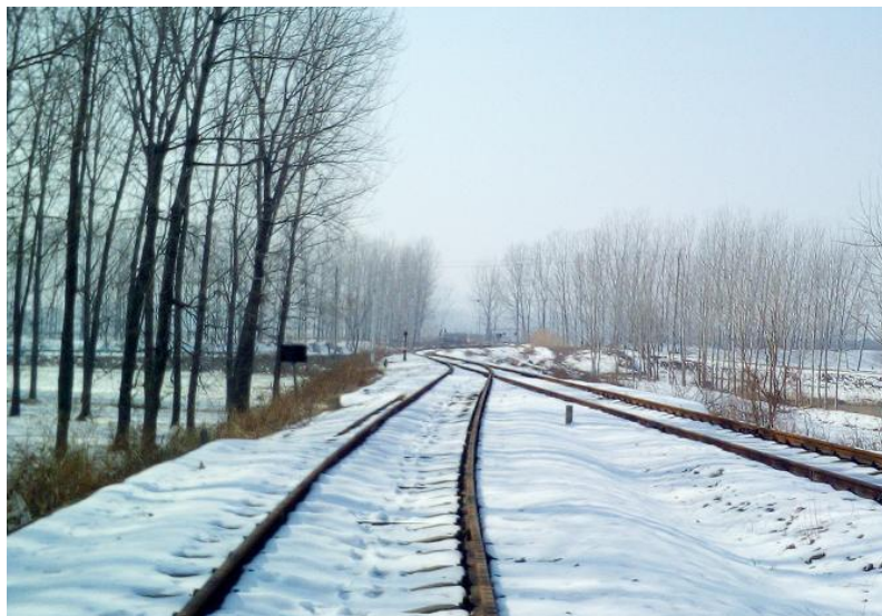
图 2.4-2 卸车线处道岔
