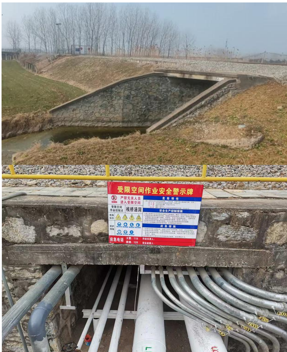
图 2.4-4 库外桥涵、库内涵洞概貌
