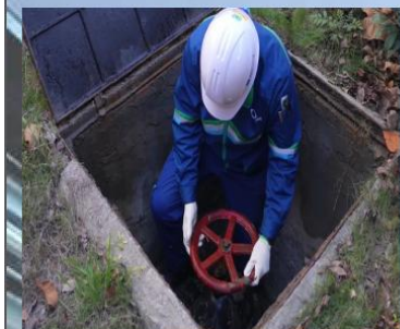
污染预防组 关闭雨水排放阀
