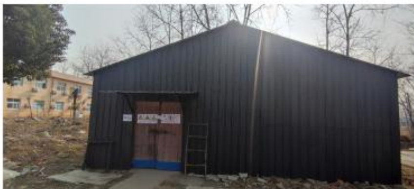
维修间已停用
